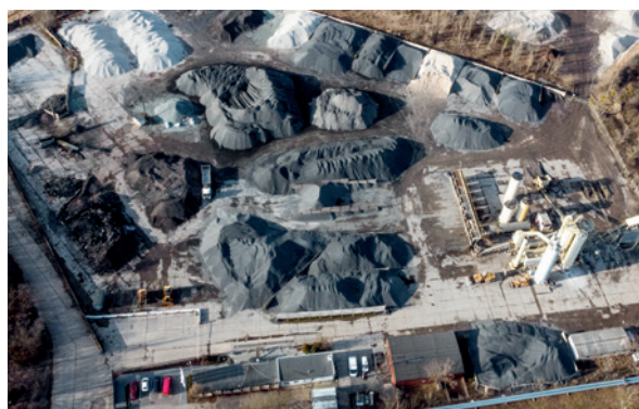
Wytwórnia Mas Bitumicznych ONDE SA w Toruniu
