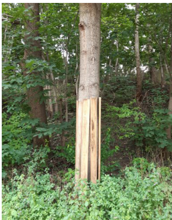
Osłona przypniowa drzew na budowie na przykładzie trasy tramwajowej wzdłuż ul. Kujawskiej w Bydgoszczy
