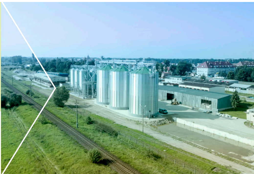
Budowa kompleksu silosów zbożowych wraz z koszem zsypowym w Bocheńcu, zrealizowana przez ONDE SA Inwestor: DACSA Sp. z o.o.
