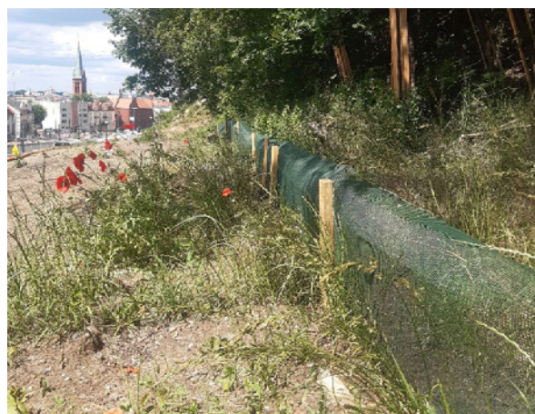
Zastosowanie wygradzeń z siatki PCV na budowie trasy tramwajowej w Bydgoszczy
