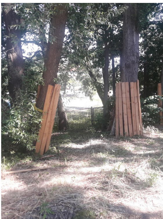
Osłona przypniowa drzew na budowie na przykładzie trasy tramwajowej wzdłuż ul. Kujawskiej w Bydgoszczy
