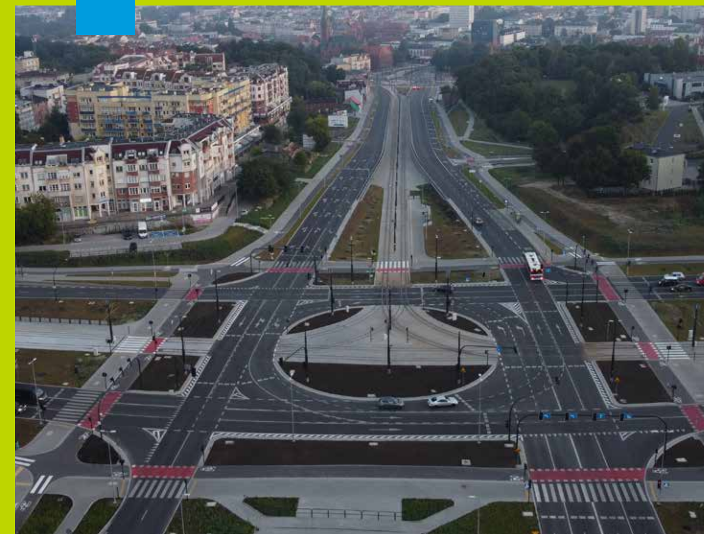
Budowa prawie 2 km linii tramwajowych. Zwiększenie dostępności transportu miejskiego, ograniczenie zanieczyszczenia hałasem, budowa parkingów „Parkuj i Jedź” oraz ponad 4,5 km ścieżek rowerowych ze stacjami rowerów miejskich, elementy zapobiegające przemieszczaniu się małych zwierząt. Nowatorskie wykorzystanie energii słonecznej do ekozasilania aktywnych znaków drogowych.
