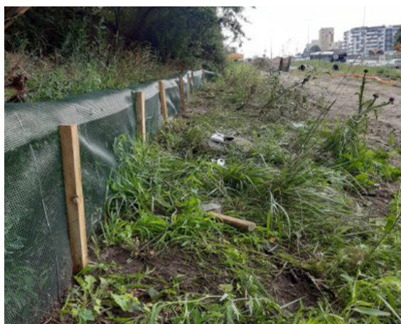
Zastosowanie wygradzeń z siatki PCV na budowie trasy tramwajowej w Bydgoszczy
