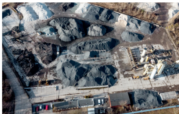
Wytwórnia Mas Bitumicznych ONDE SA w Toruniu
