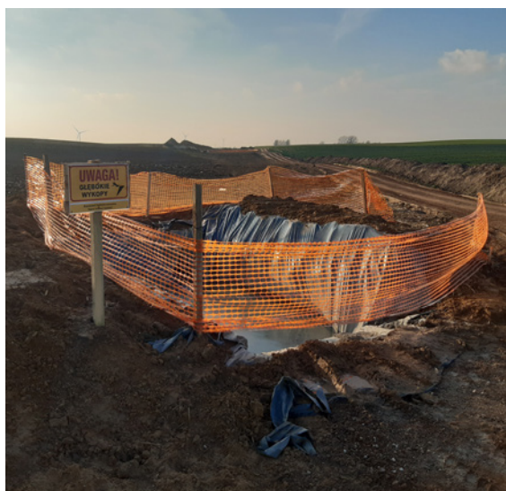
Przykład organizacji miejsca do mycia betonowozów
