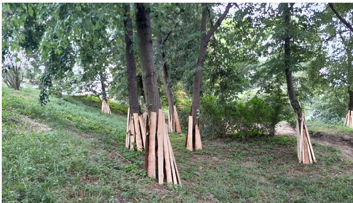
Ostry przypniowe drzew na budowie na przykładzie „Przebudowy Bulwaru Filadelfijskiego w Toruniu”
