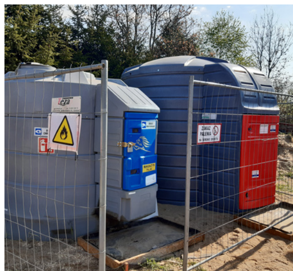
Miejsce do tankowania paliwa z uszczelnionym podłożem oraz sorbentem na wypadek wycieku
