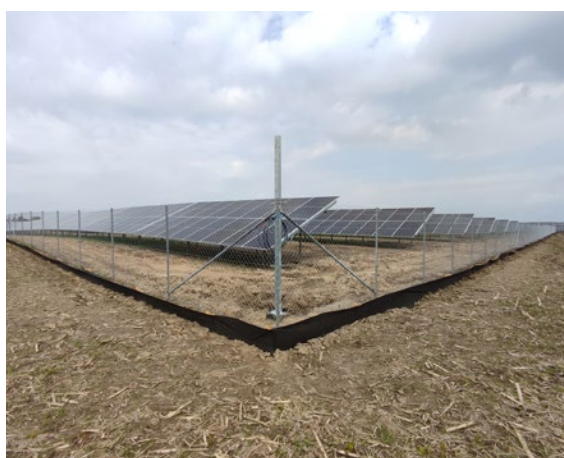
Zastosowanie wygradzeń na budowie PV Buszkowo
