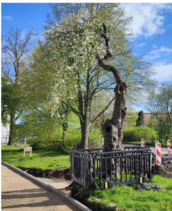
Ostony przypniowe drzew na budowie na przykładzie „Przebudowy Drogi Wojewódzkiej 163 w Kotobrzegu”
