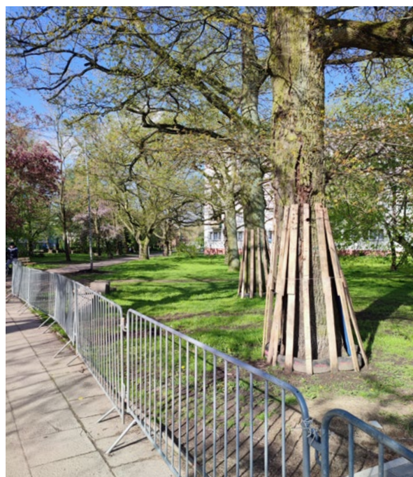
Ostony przypniowe drzew na budowie na przykładzie „Przebudowy Drogi Wojewódzkiej 163 w Kotobrzegu”
