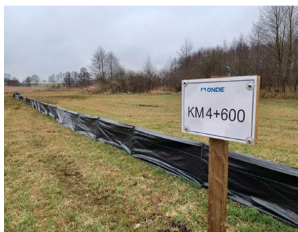
Zastosowanie wygradzeń na budowie Obwodnicy Lubrańca
