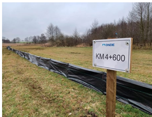
Zastosowanie wygradzeń na budowie Obwodnicy Lubrańca
