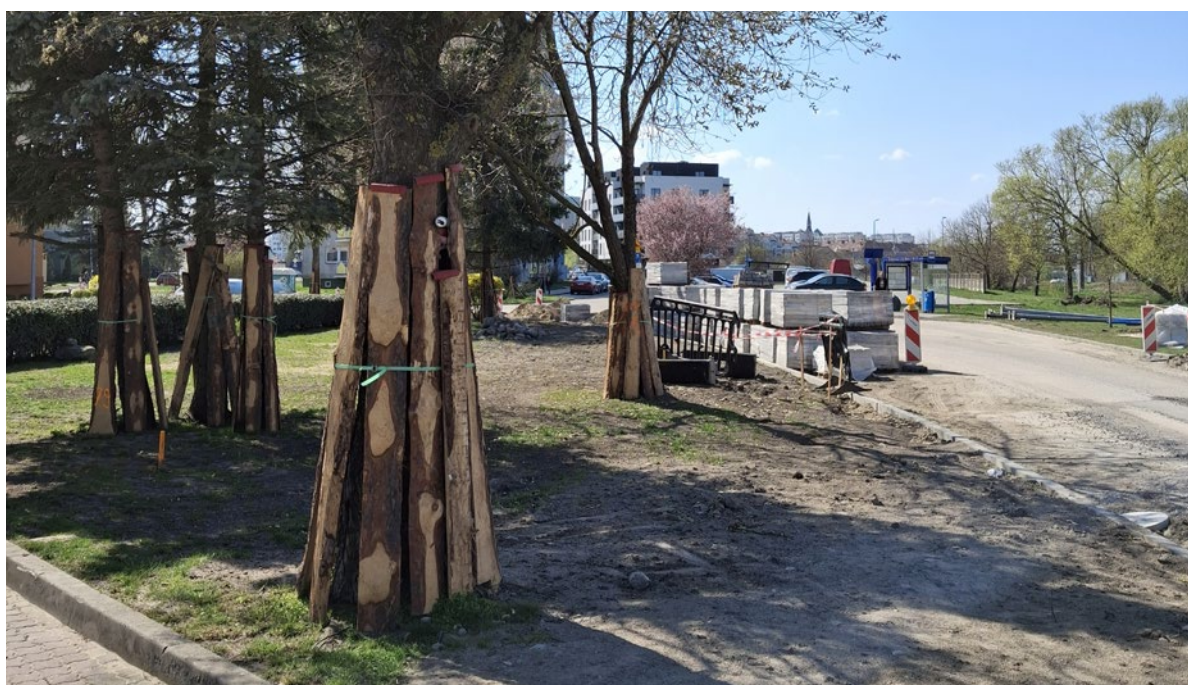
Ostry przypniowe drzew na budowie na przykładzie „Remontu ul. Chodkiewicza w Kotobrzegu”
