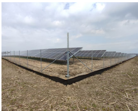
Zastosowanie wygradzeń na budowie PV Buszkowo
